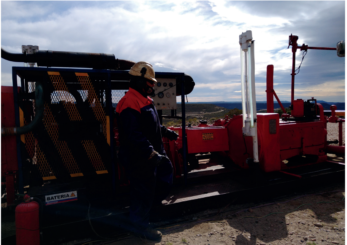
Trabajador controlando circuito de operación de bombas en equipo de workover
