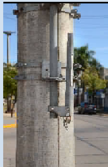
Candado de seguridad inmovilizado a través de un seguro con candado.
